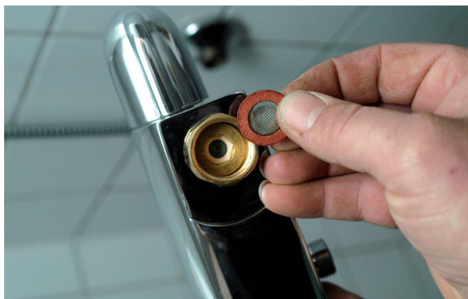
Vergeet niet de pakkingringen te monteren.
