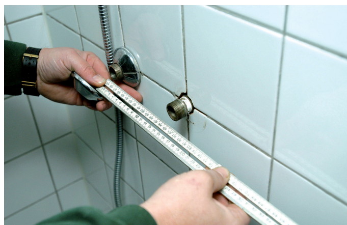
Meet de hartafstand tussen de waterleidingen.
