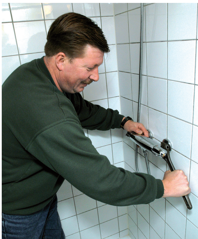
Draai de moeren aan met een passende steeksleutel.
