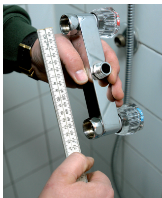
De hartafstand van de inbouwkraan.
