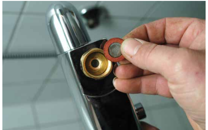
Vergeet niet de pakkingringen te monteren.
