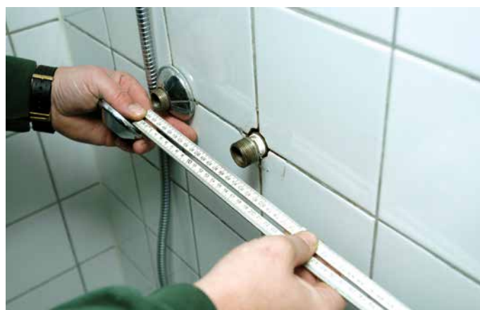
Meet de hartafstand tussen de waterleidingen.
