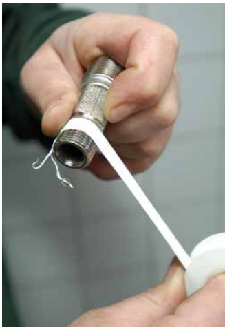
Wikkel teflon-tape om de schroefdraad van de S-koppeling.
