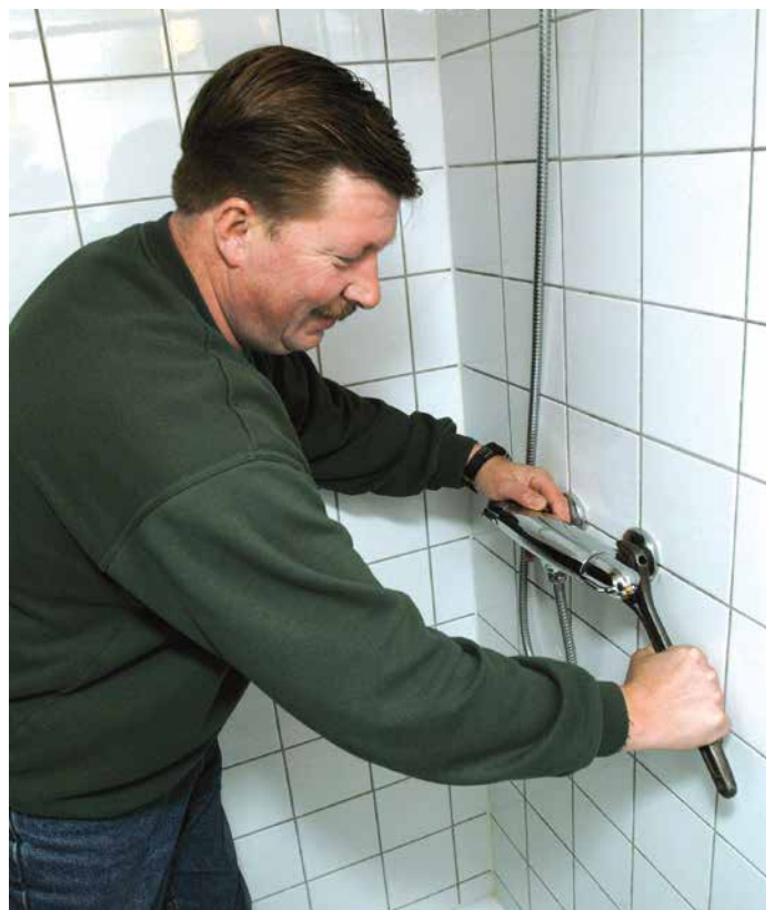
Draai de moeren aan met een passende steeksleutel.
